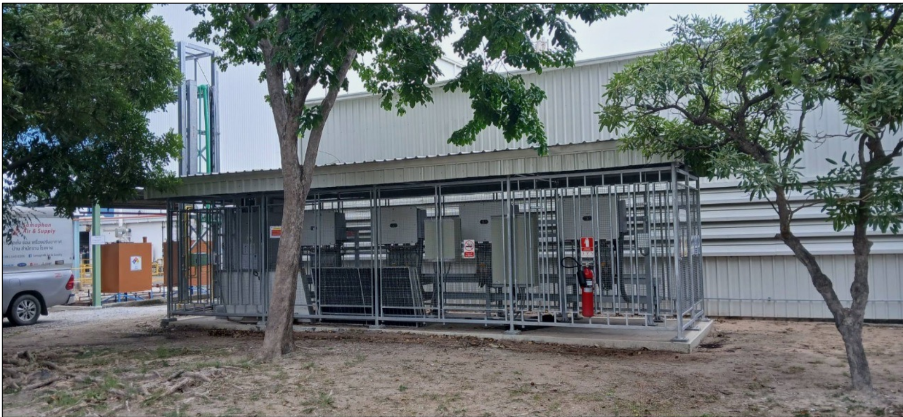
ภาพที่ 1.7 การติดตั้งเครื่องแปลงกระแสไฟฟ้า (Inverter) บริเวณด้านหลังอาคารสาสการผลิตแผ่นเหล็กเคลือบโลหะ 1 (MCL1)
